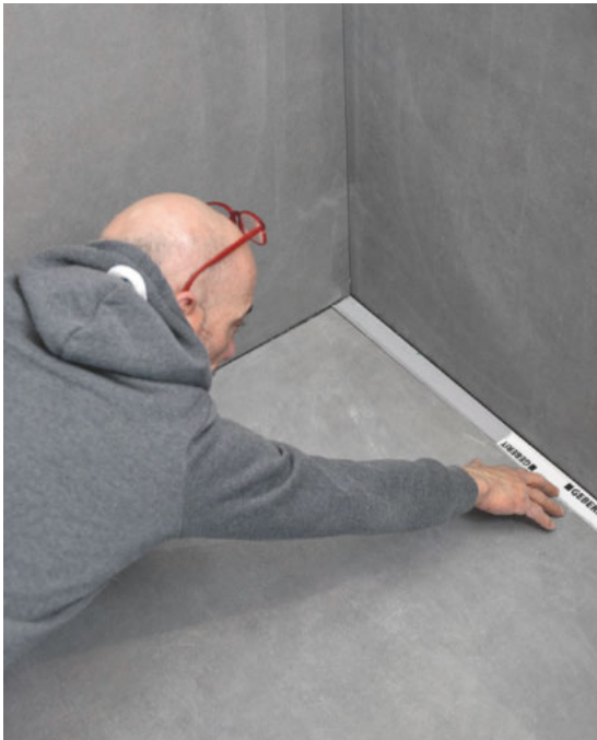
↑ Rene linjer: Det integrerte fallet gjør at Geberit CleanLine80 slukrenne sikrer effektivt dusjavløp.
