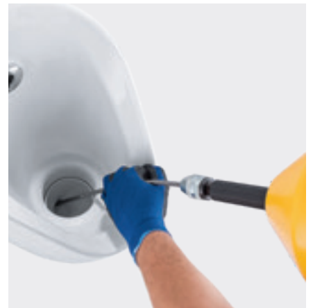
↑ Vannlåsen er lett tilgjengelig ovenfra, slik at urinalet ikke trenger å fjernes for vedlikehold eller rengjøring.
