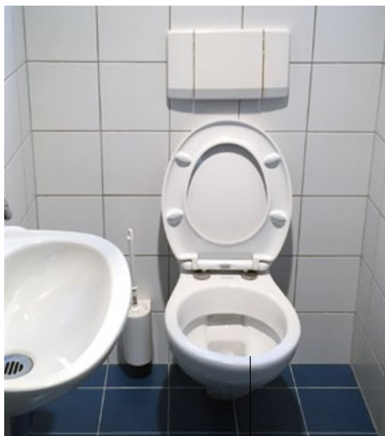
FØR: vanlig vegghengt toalett i badet i en utleiebolig
