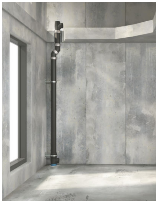
← Slik gjøres en installasjon vanligvis uten Geberit Silent-db20 Offset-bend.
