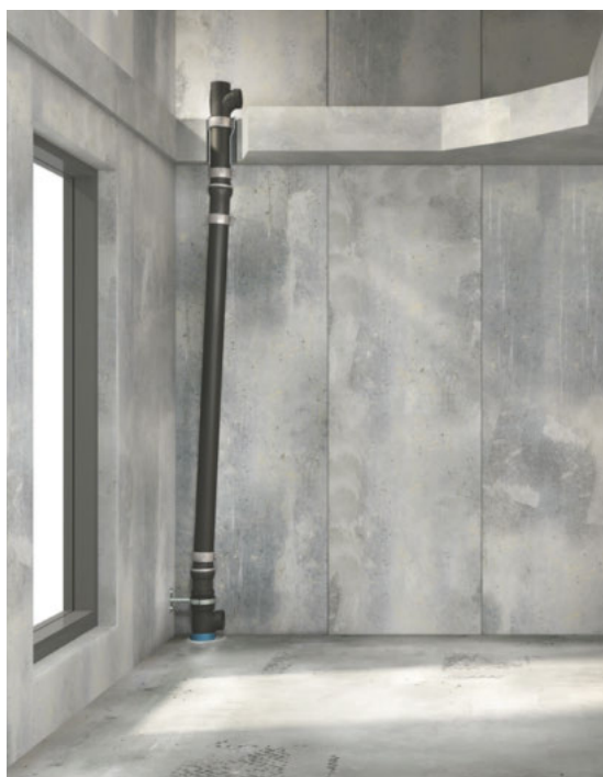
← Med to av de nye bendene kan en liten forskyvning i stigerørert enkelt korrigeres.
